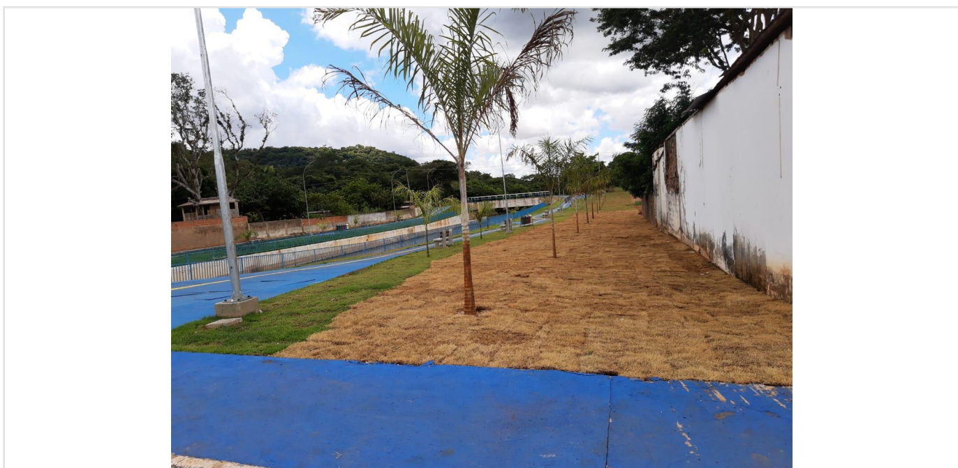
Terreno - lateral direita Data da última atualização: 18/06/2020
